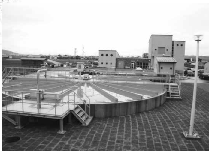
オキシデーションデッチ槽(中央)と管理汚泥棟(右奥)
